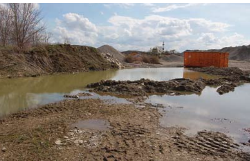
Der zentrale Teil des Kieswerks Obermayr – trotz und gerade wegen des Betriebs ein wertvoller Lebensraum für die Wechselkröte.
